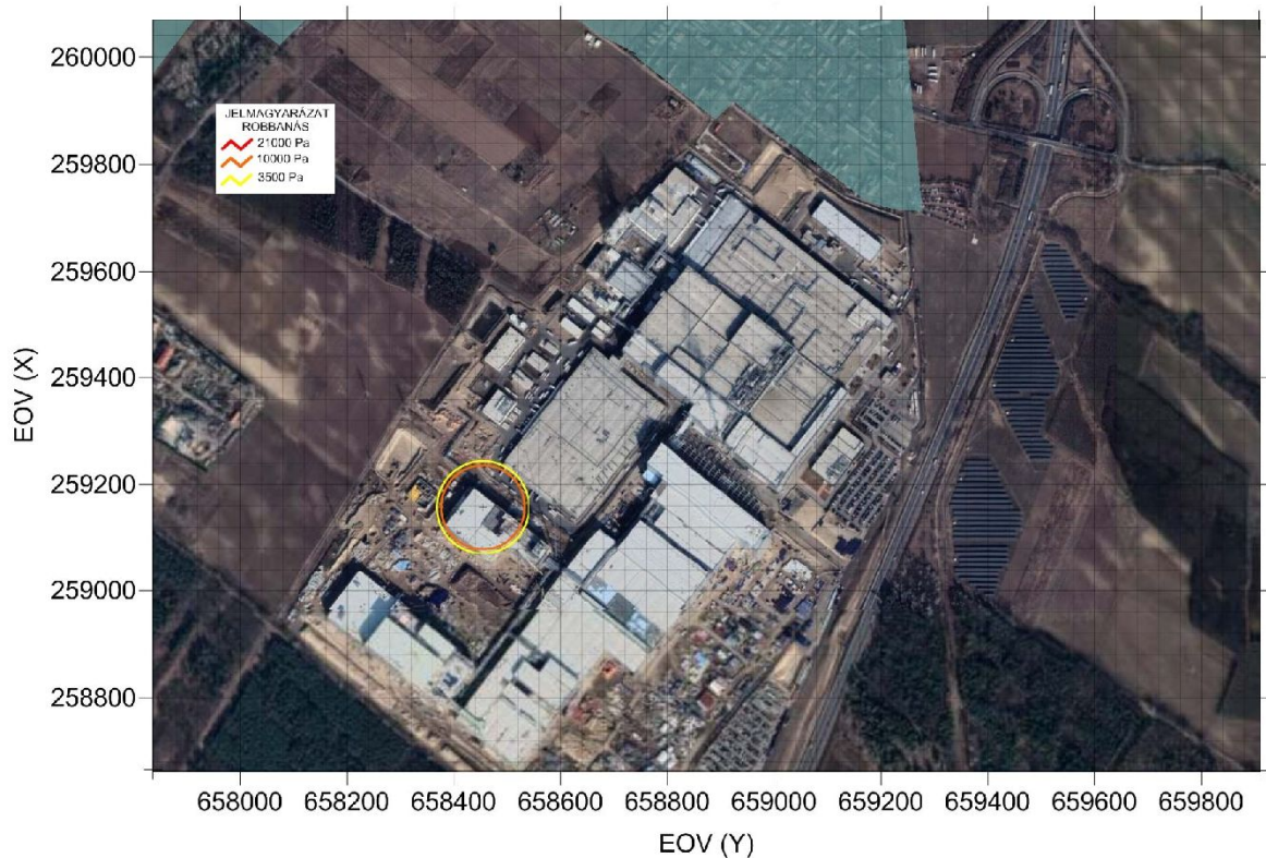
Az FGR2_1.1.1_A következmény robbanás esetén
