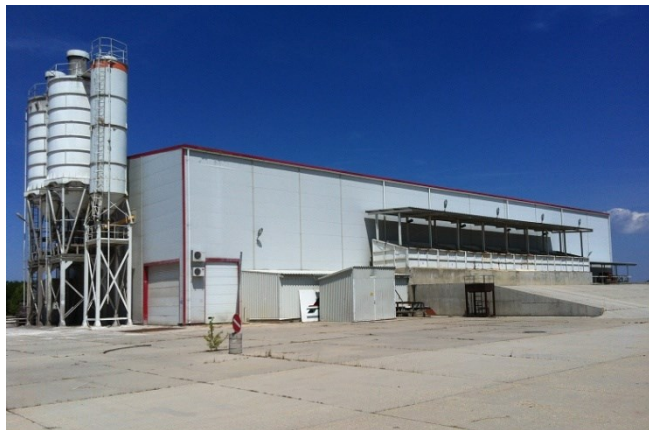
Az itt alkalmazott technológia nem idéző elő környezeti zajterhelést (ABeton Majosháza, Térkövő üzem)
